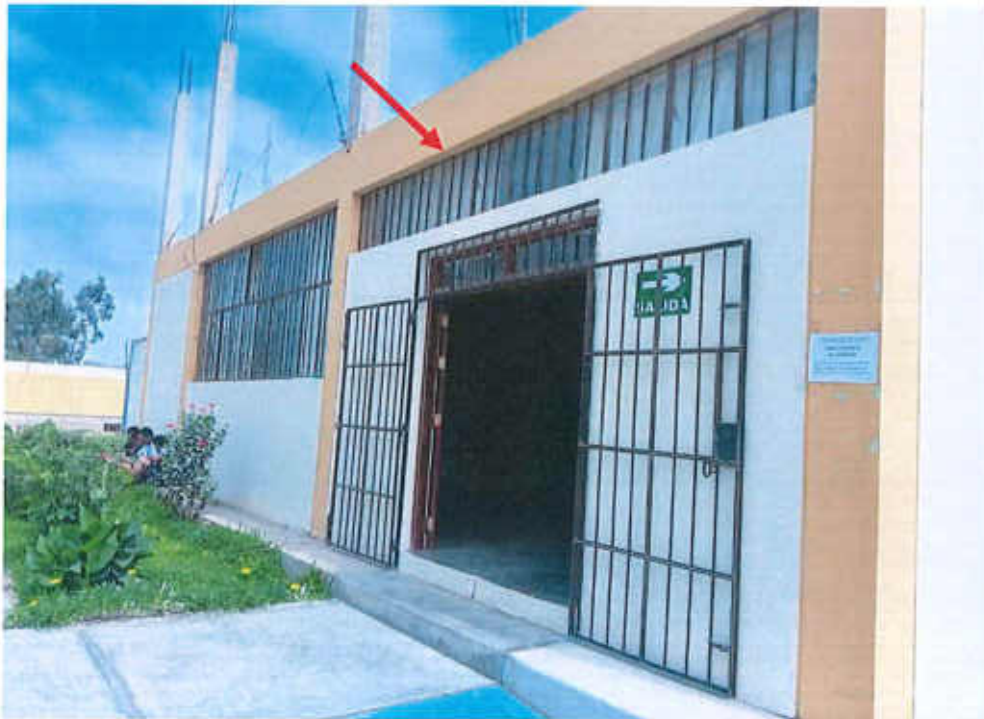
Fotografía 22. B-72 (SINDICATO DE TRABAJADORES) Elevación Frontal. Laminado de vidrio.
