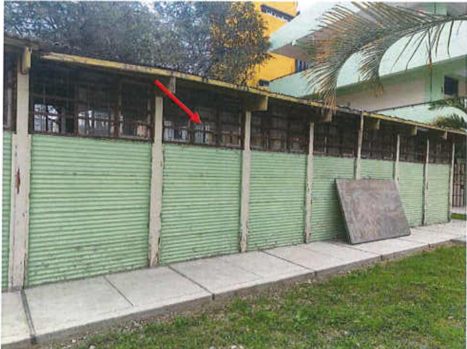
Fotografía 6. T-3 Barraca Elevación posterior. Laminado de vidrio y reemplazo de vidrio roto.
