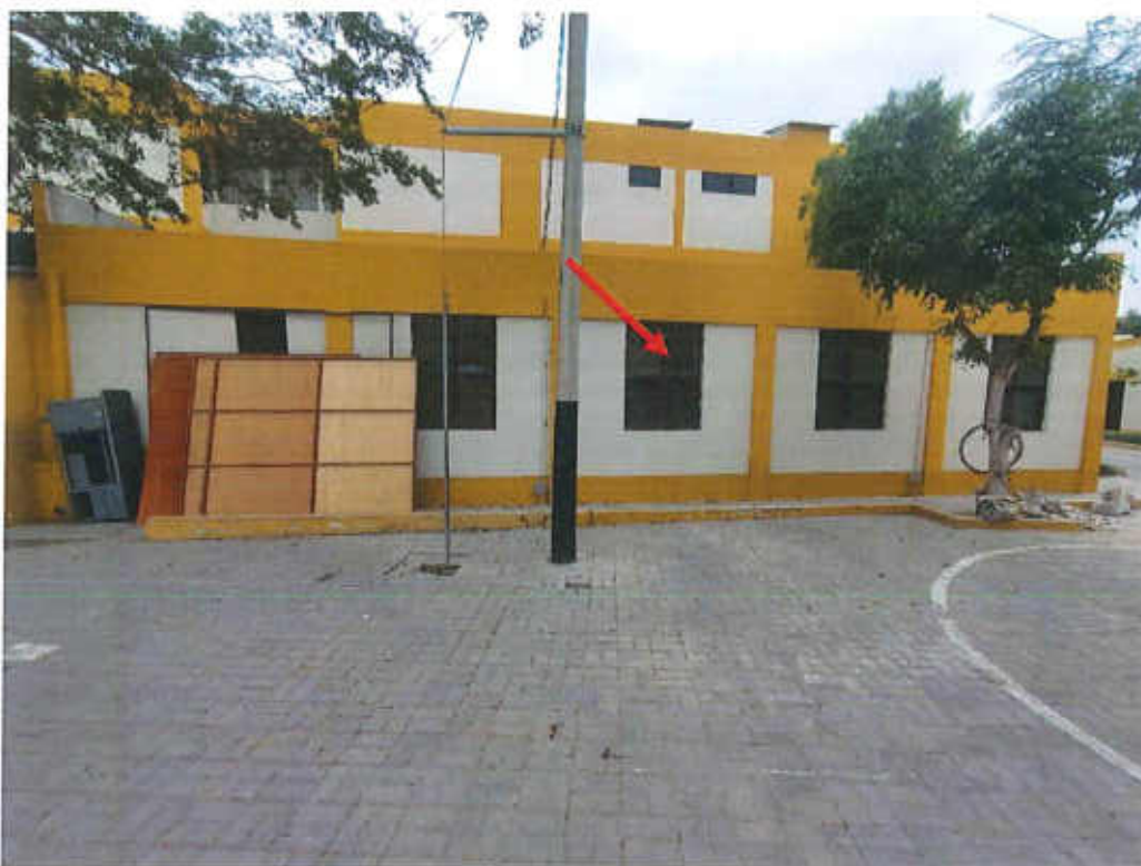
Fotografía 9. B-78 (Obras) Elevación frontal. Laminado de vidrio e instalación de vidrio.
