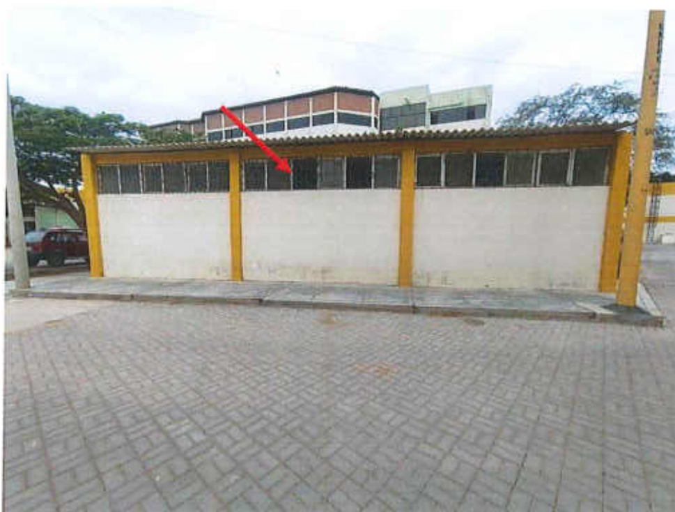
Fotografía 12. B-18A (Almacén FACHSE) Elevación posterior. Laminado de vidrio y reemplazo de vidrio roto
