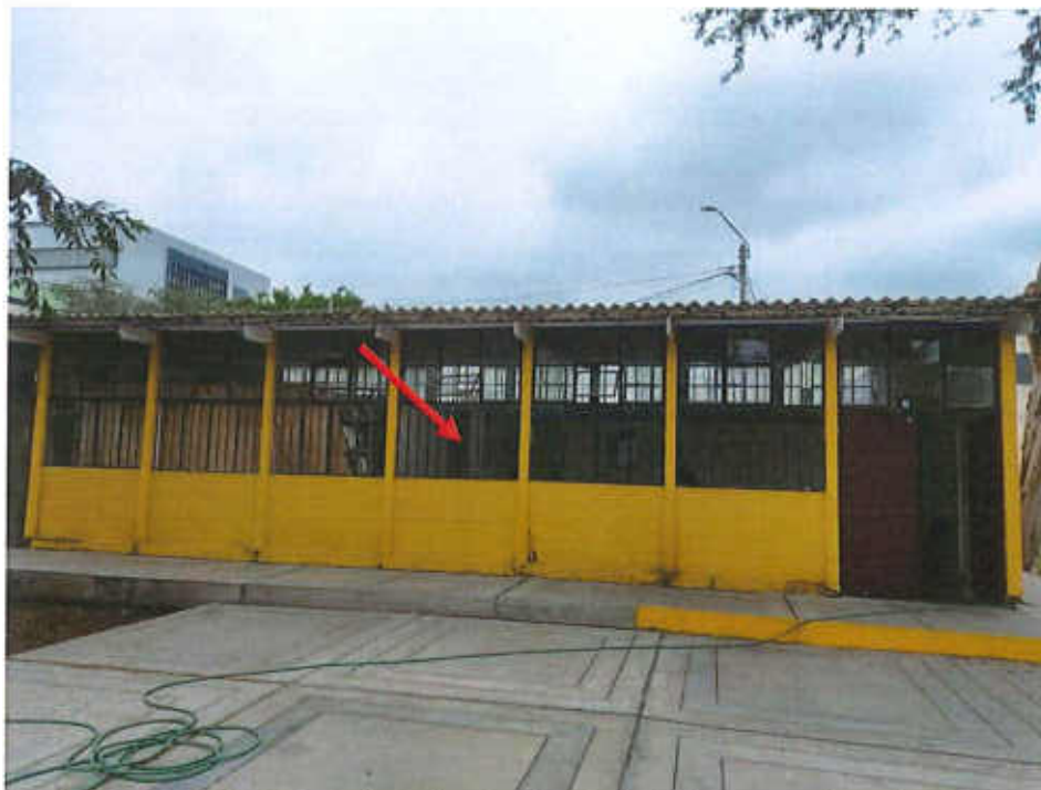
Fotografía 1. T6 BARRACA Parte derecha. Laminado de vidrio y reemplazo de vidrio roto.
