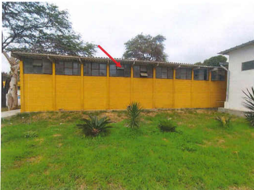
Fotografía 4. T6 BARRACA Elevación posterior. Laminado de vidrio y reemplazo de vidrio roto.
