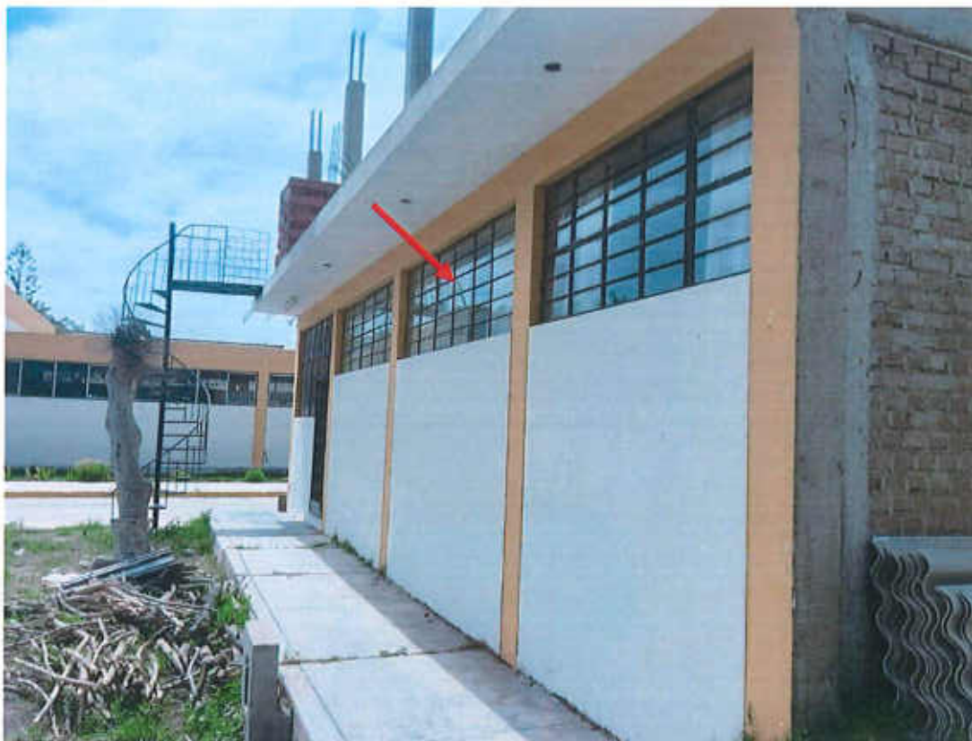
Fotografía 23. B-72 (SINDICATO DE TRABAJADORES) Elevación Posterior. Laminado de vidrio.
