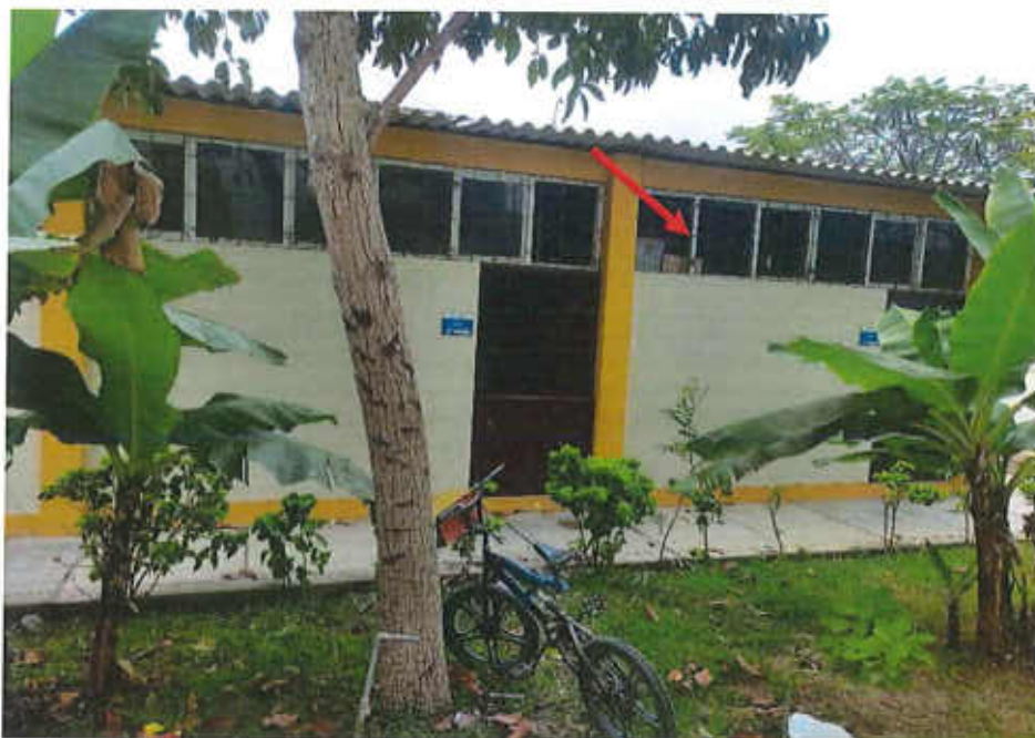
Fotografía 11. B-18A (Almacén FACHSE) Elevación frontal. Laminado de vidrio y reemplazo de vidrio roto
