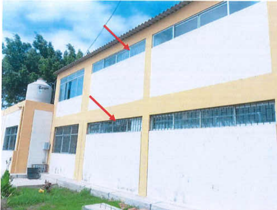
Fotografía 21. B-61 (DGA) Elevación Frontal. Laminado de vidrio (Todas las ventanas perimetrales).
