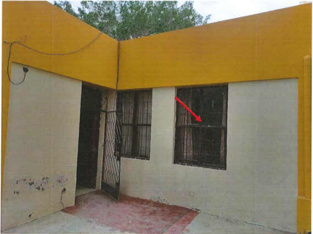
Fotografía 8. B-78 (Obras) Elevación lateral. Laminado de vidrio.
