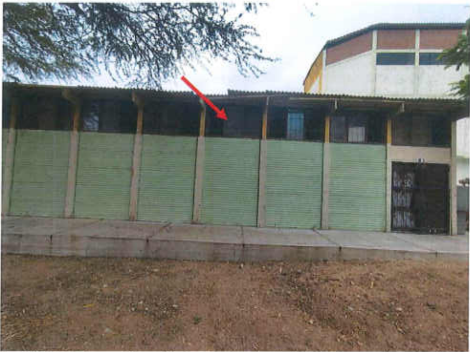
Fotografía 7. T-3 Barraca Elevación frontal. Laminado de vidrio y reemplazo de vidrio roto.
