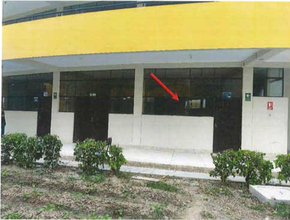
Fotografía 13. B-20 (FACHSE – Edificio Curvo). Laminado de vidrio y reemplazo de vidrio roto.
