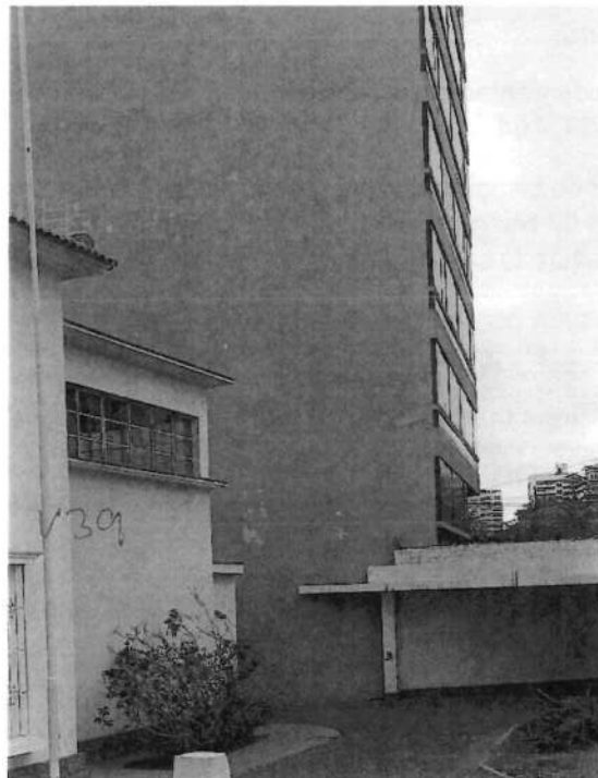
IMAGEN. V39 VENTANA A RETIRAR EN SEGUNDO NIVEL
