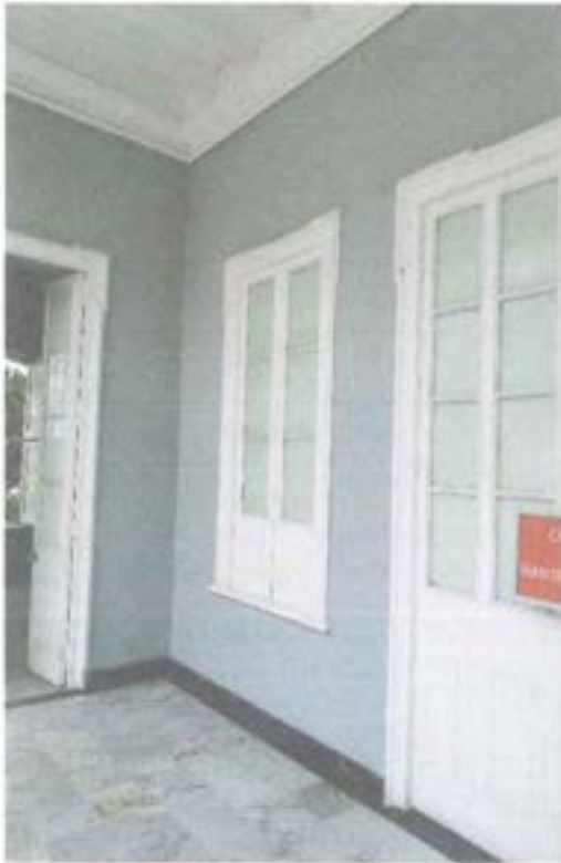
Foto 10 Pintado de puertas, ventanas y Molduras de madera en cielo raso
