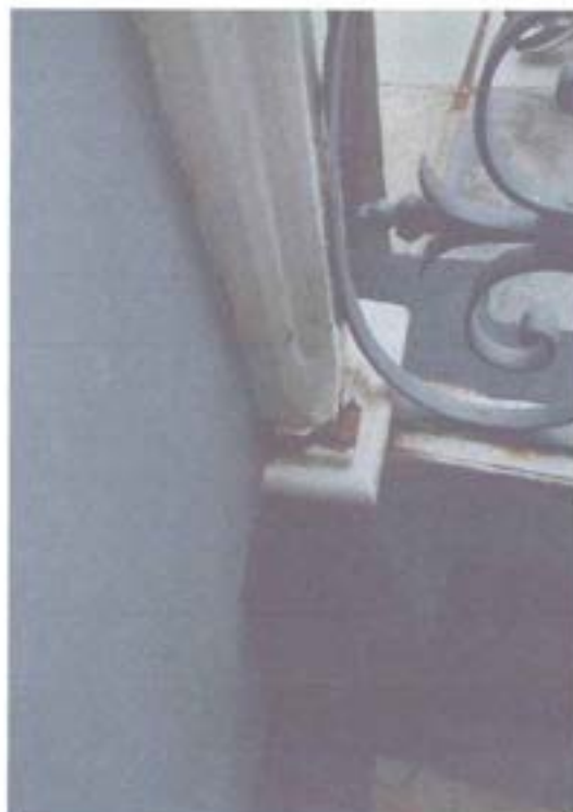
Foto 09 reparación de marco de madera
