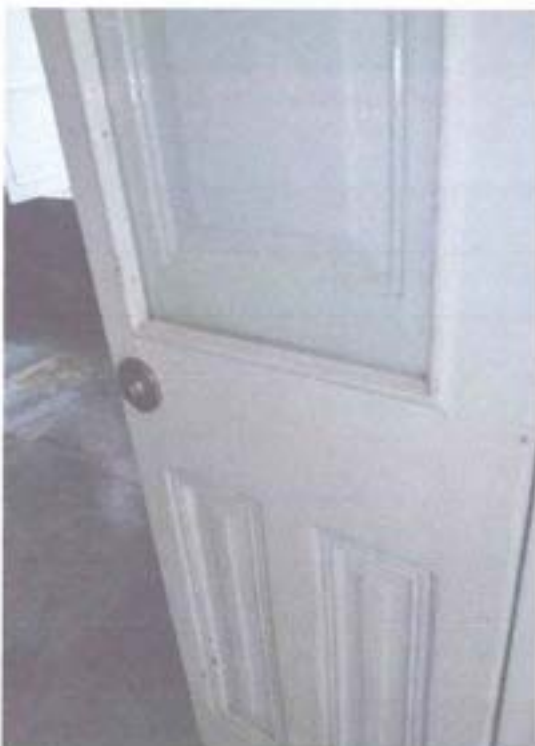
Foto 08 pintado de puerta y colocación de chapa
