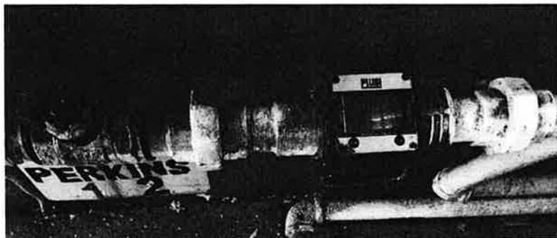
Medidor N° 3: Atico - Medidor entrada grupo electrógeno, para Perkins 1 y Perkins 2 (de 1")
