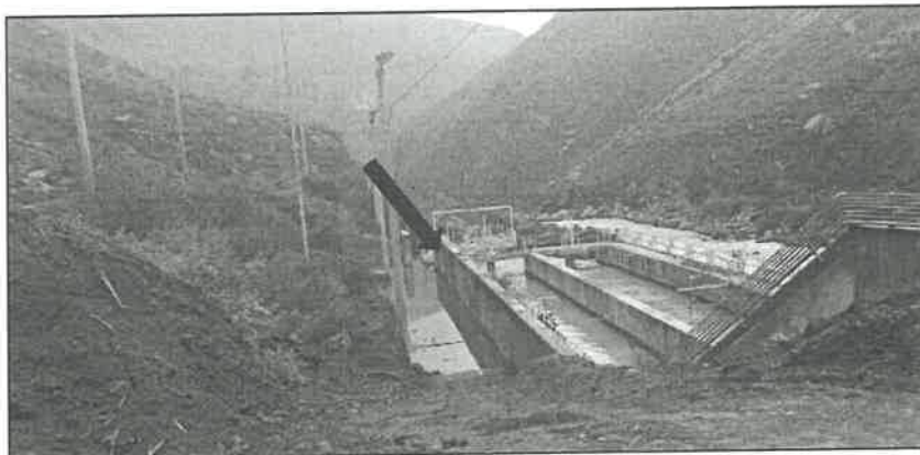
Ilustración 3 Muro bajo de protección
