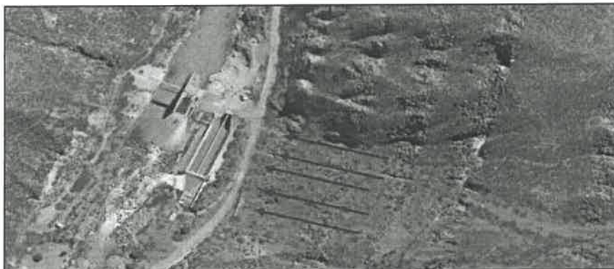
Ilustración 1 Área de afectación ante el deslizamiento de lodo y rocas
