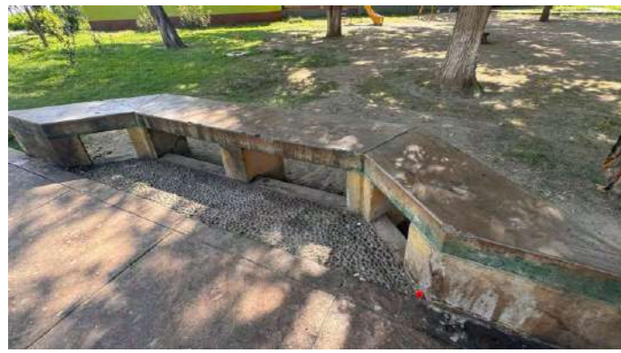
IMAGEN 02: BANCA DE CONCRETO
