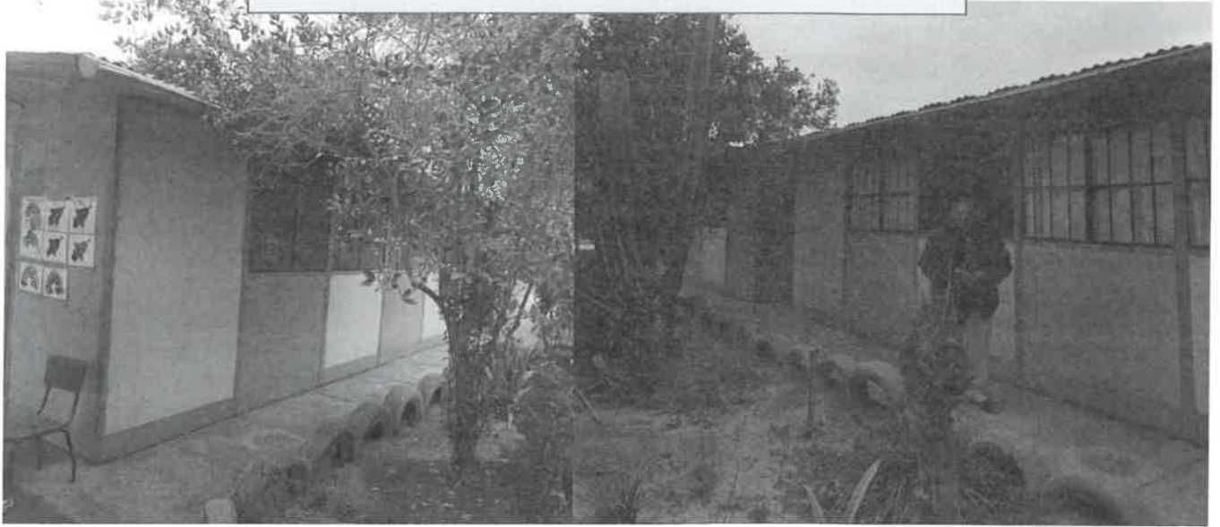
Imagen N°02: Vista Panorámica de los módulos prefabricados
