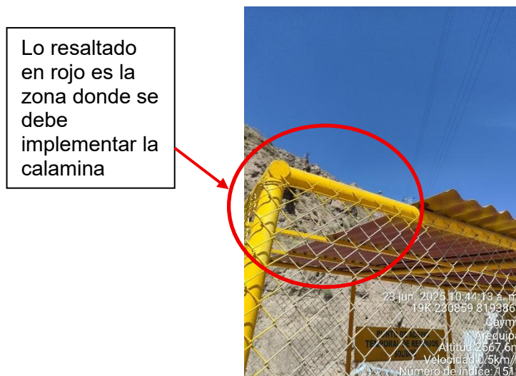
Imagen N°1: Techo almacén temporal de residuos de Charcani I
