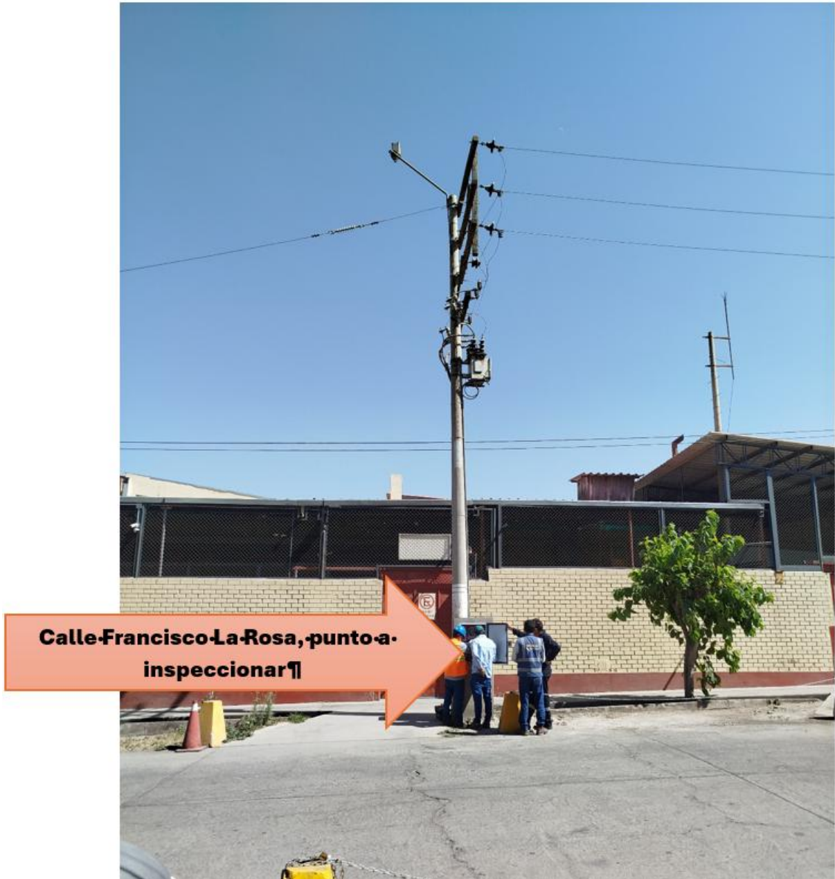
Ilustración 2. Primer punto de suministro a cliente a inspeccionar
