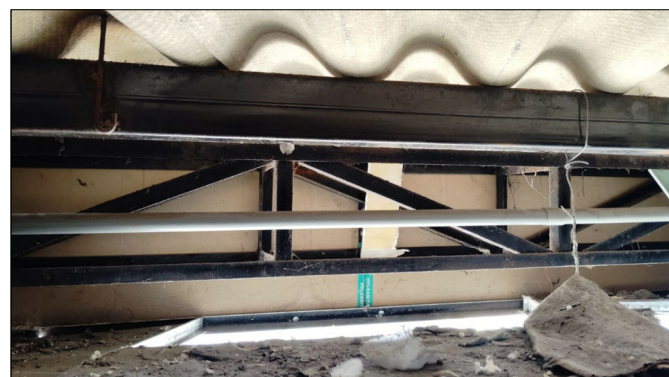
VIGA Y COBERTURA EXISTENTE
