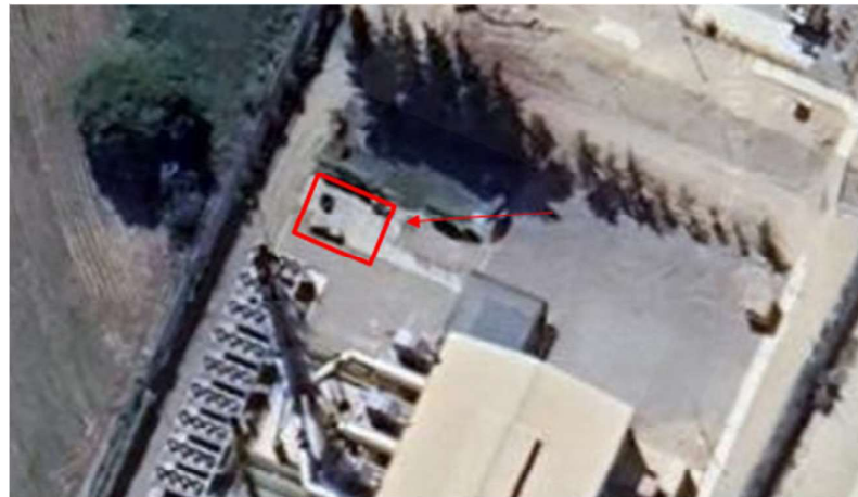
Figura 04: Lavado de filtros
