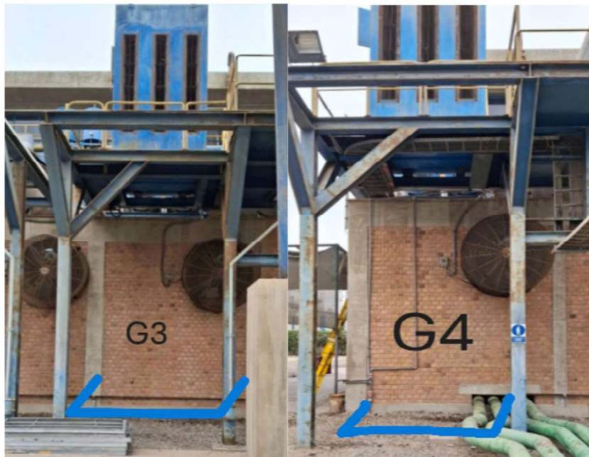
Figura 07: Adecuación de losa para filtros de aire de carga de G3 y G4
