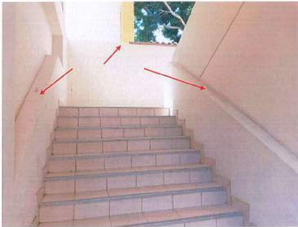
Fotografía 4. Escalera en U Bloque B-21 (Edificio 4).
