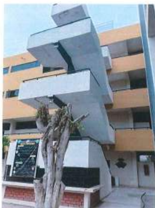
Fotografía 13. Escalera Bloque B-39 (Edificio 10).
