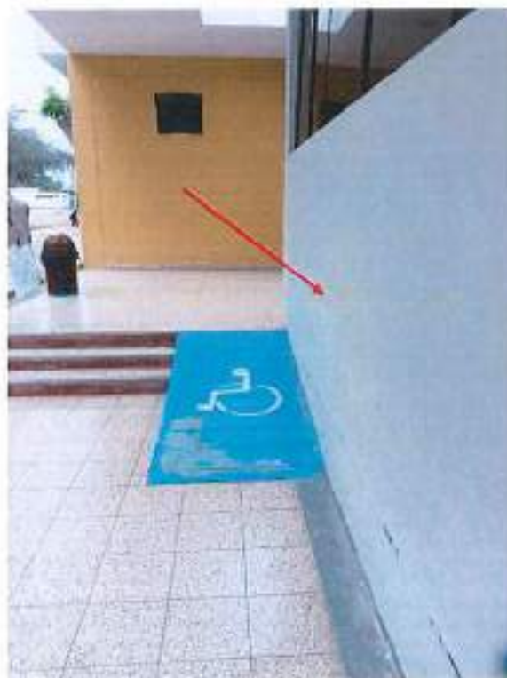
Fotografía 8. Entrada a Rectorada Bloque B-59 (Edificio 7).
