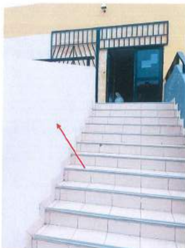
Fotografía 19. Escalera en U Bloque B-32 (Edificio 14)
