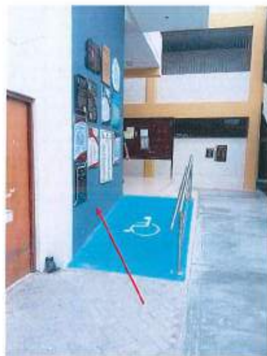
Fotografía 1. Entrada Auditorio FICSA (Edificio 1).
