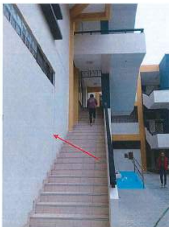
Fotografía 12. Escalera Bloque B-35 (Edificio 01).
