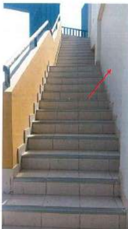
Fotografía 15. Escalera Lineal 2 del bloque B-20 (Edificio 11).
