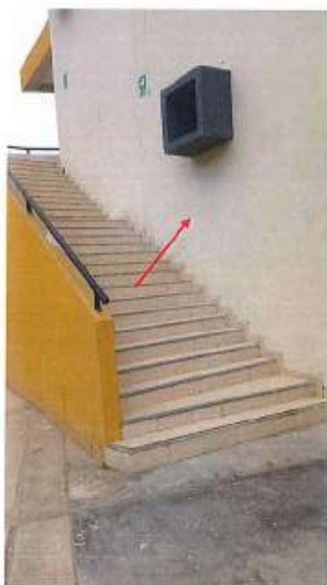
Fotografía 14. Escalera Lineal 1 del bloque B-20 (Edificio 11).
