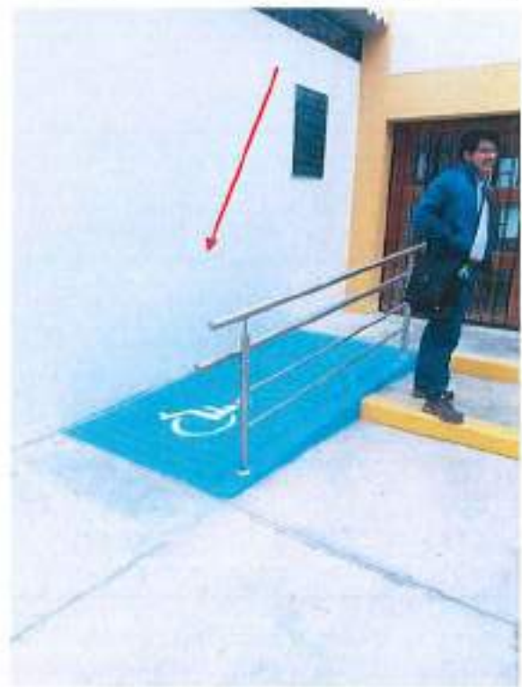
Fotografía 2. Entrada Biblioteca Bloque B-61 (Edificio 2).
