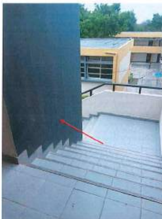
Fotografía 11. Escalera Exterior Pasamano Central Bloque B-31 (Edificio 9)
