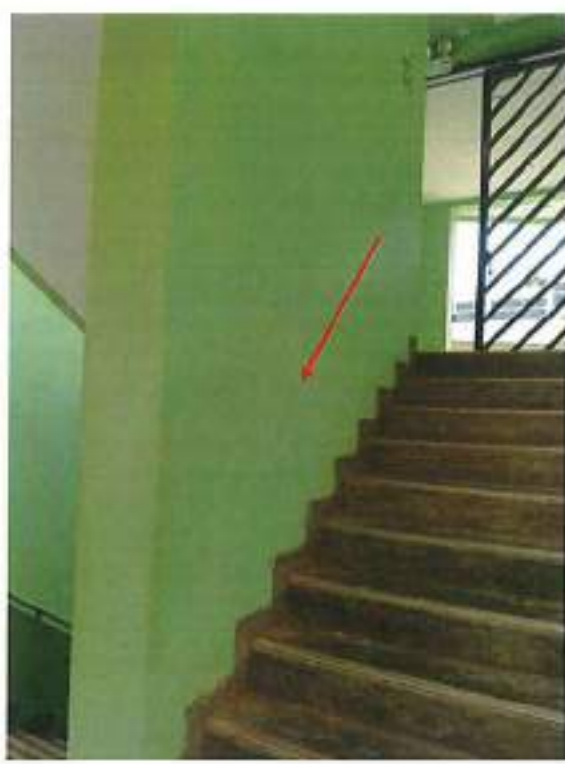
Fotografía 5. Escalera en U Bloque B-11 (Edificio 05).
