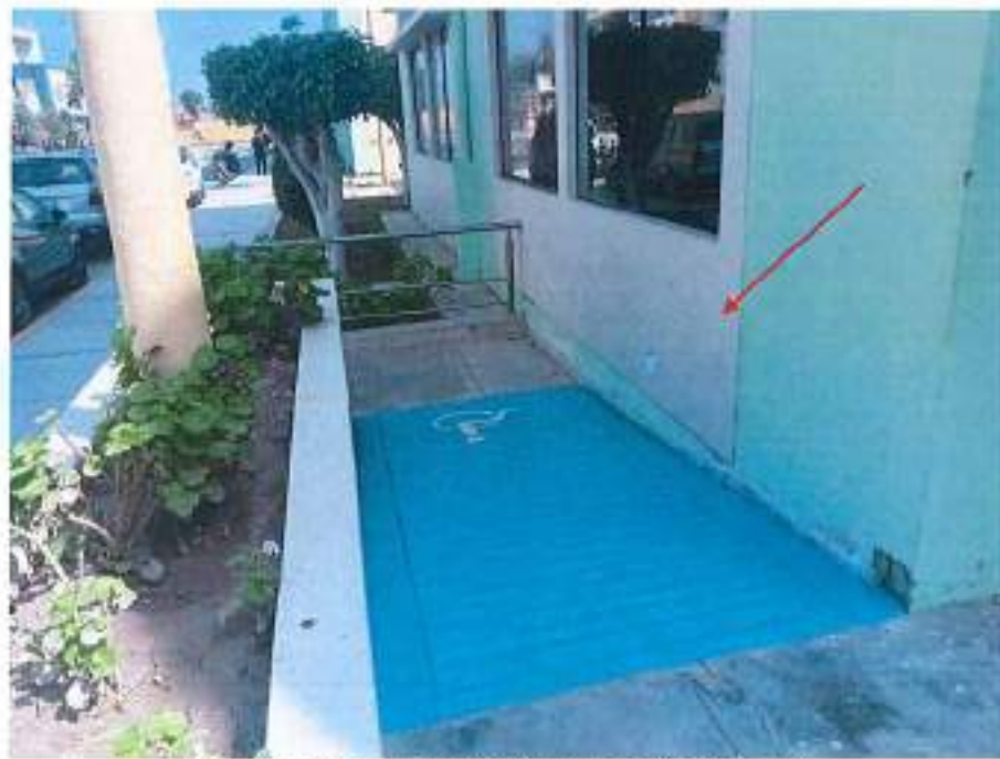
Fotografía 6. Rampas Entrada Bloque B-11 (Edificio 05).
