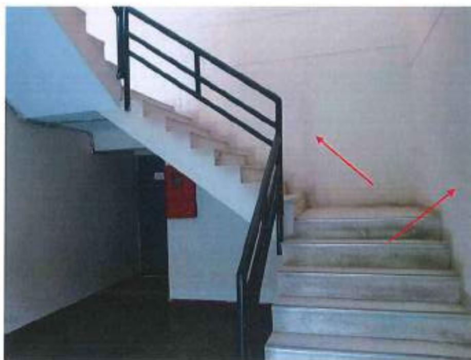
Fotografía 10. Escalera Interior Bloque B-31 Escalera Decanato FICSA (Edificio 9)
