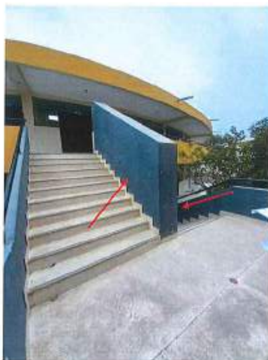
Fotografía 16. Pasamano central del bloque B-20 (Edificio 11).
