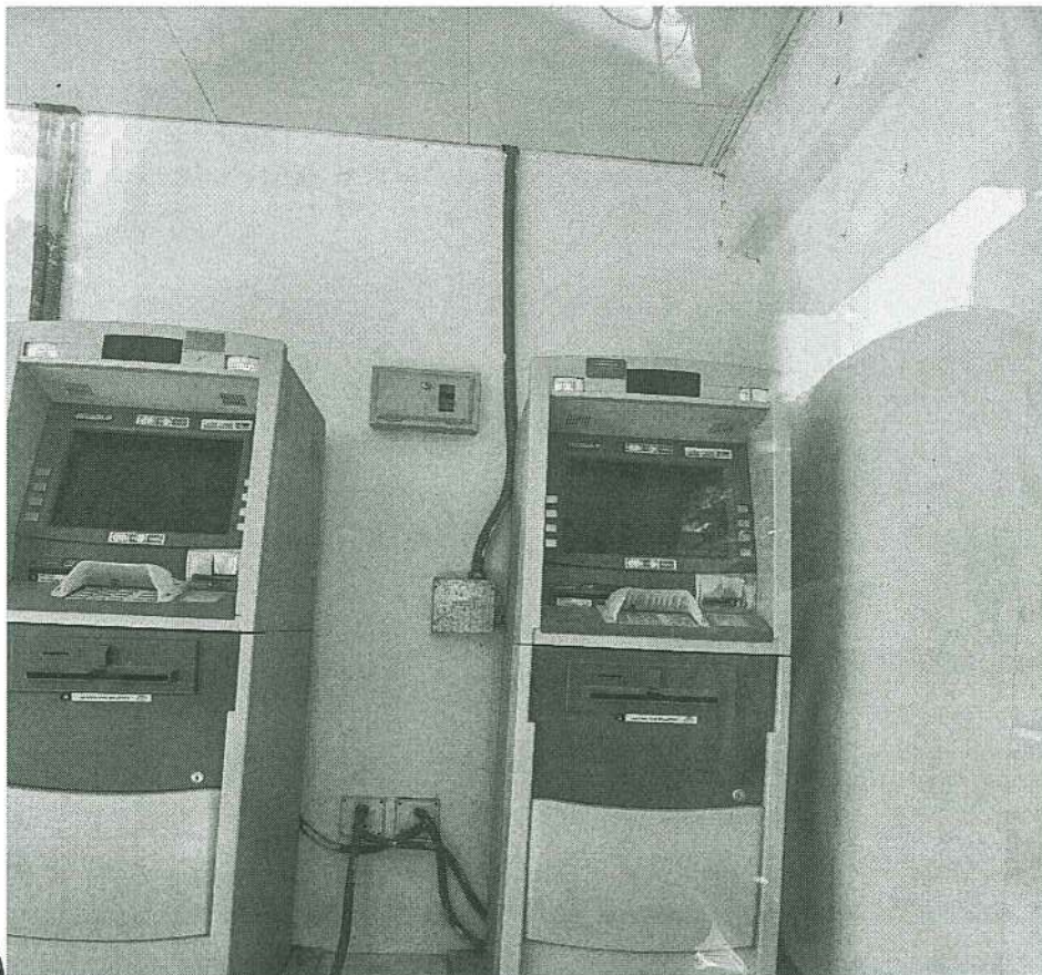
Imagen 2. Falso Cielo raso existente, piso y podios a retirar en el Lobby 1er Piso FEBAN
