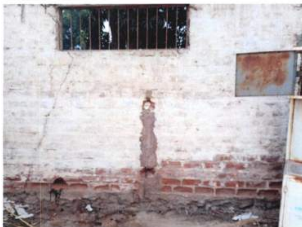
MURO DELANTERO A DEMOLER
