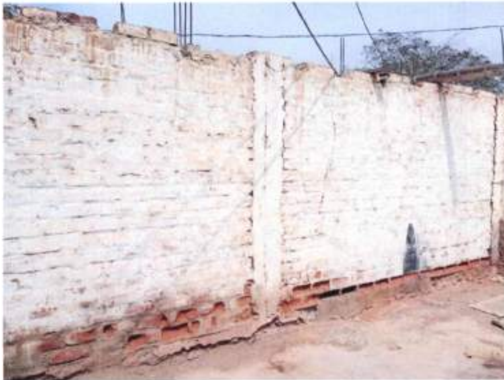
MURO LADO DERECHO A DEMOLER
