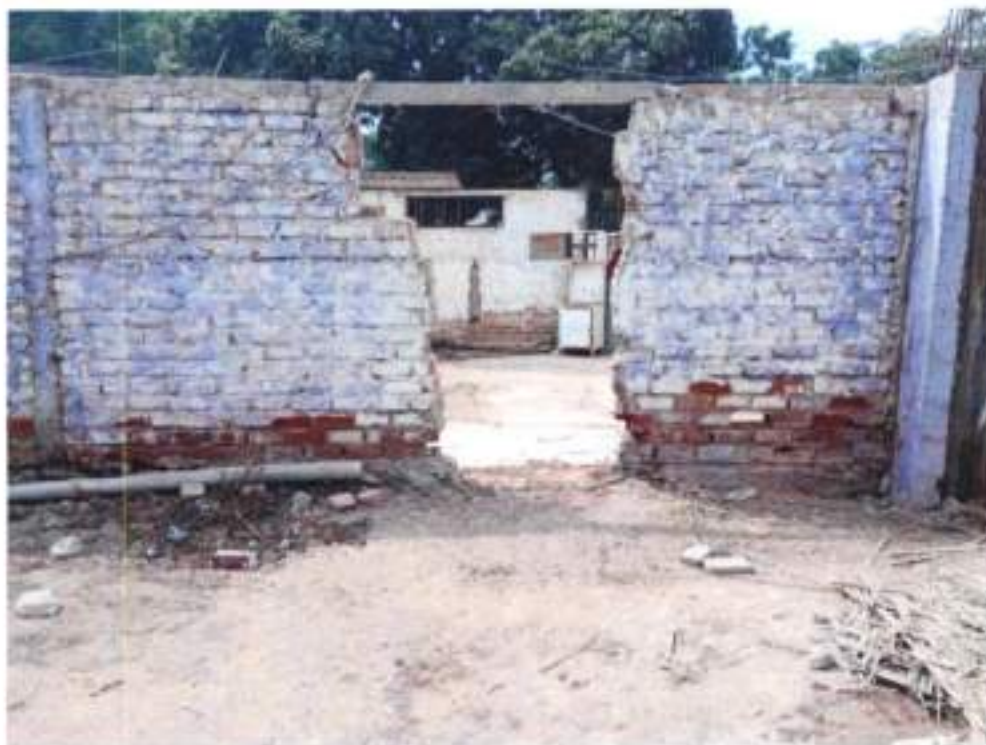
MURO POSTERIOR A DEMOLER
