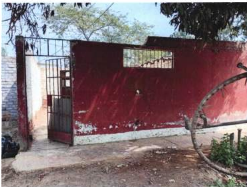
VISTA DE LA FACHADA
