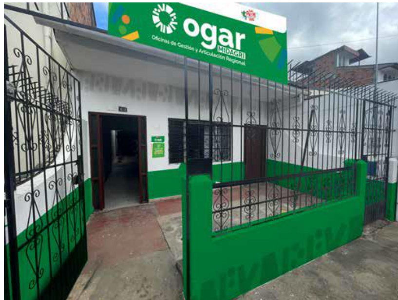
Vista de la Fachada principal
